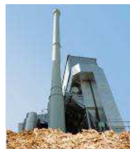
Biomasse, Biogas 8,7 TWh
